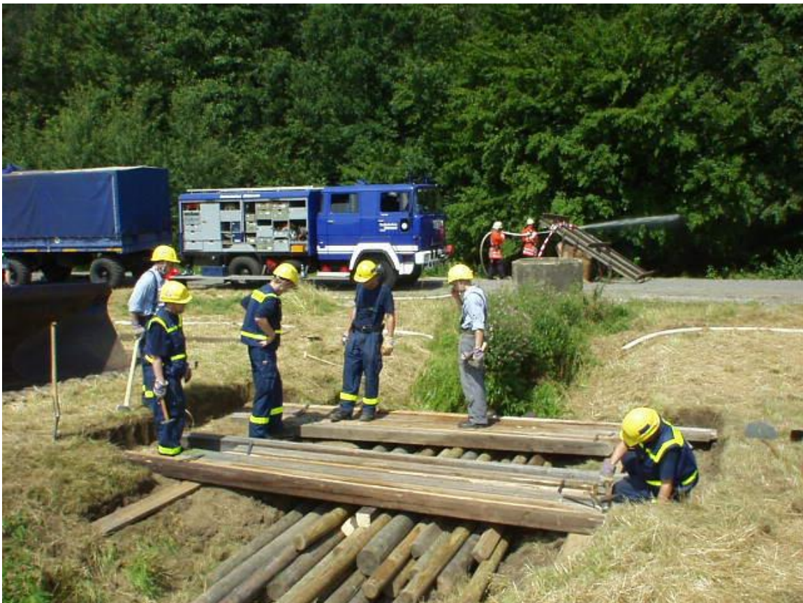
Die Bergungsgruppen waren mit dem Bau einer Grabenüberquerung beschäftigt.
