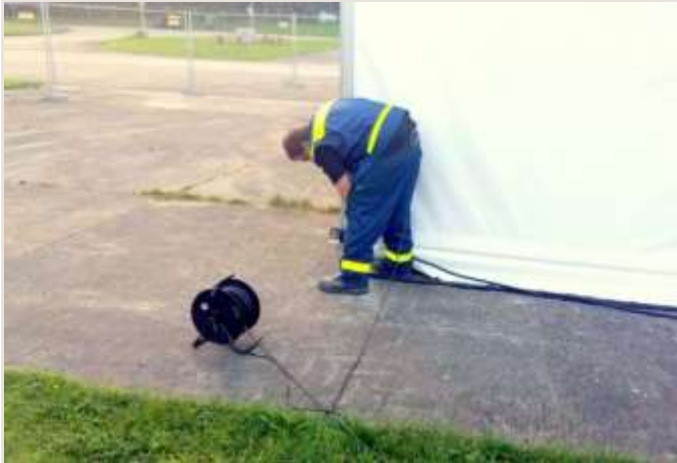
Arbeiten an den Flüchtlingsunterkünften in Ehra-Lessien
