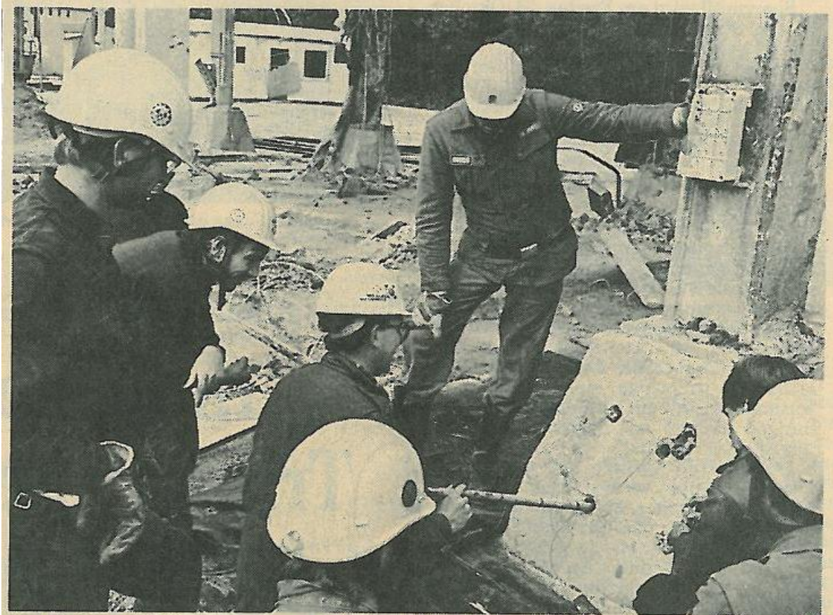
Das Technische Hilfswerk nutzte die Sprengung des Betonmischturmes zur Ausbildung von Helfern aus Peine, Sarstedt und Hildesheim.
